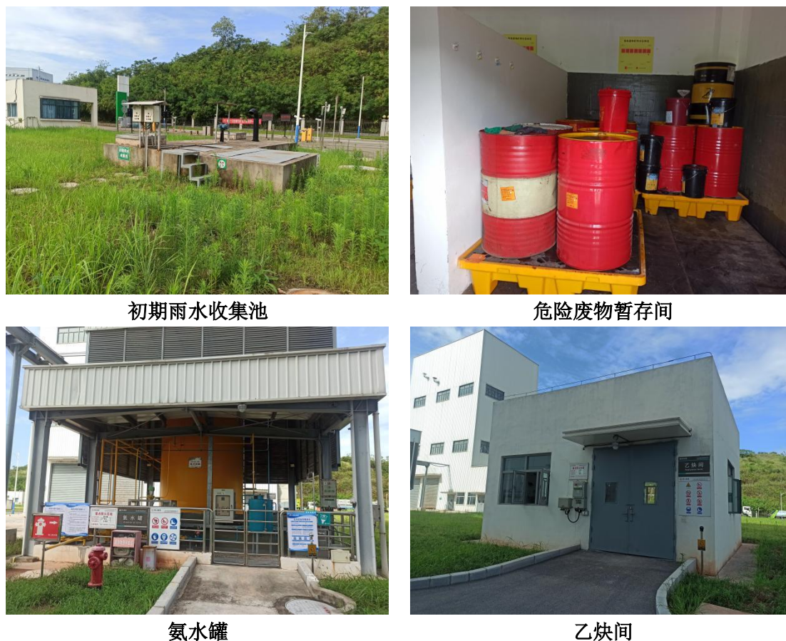
图4-3 现场踏勘照片
