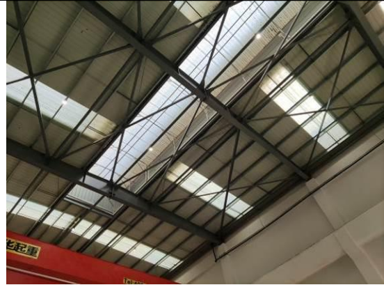
汽轮机间屋顶通风气楼
