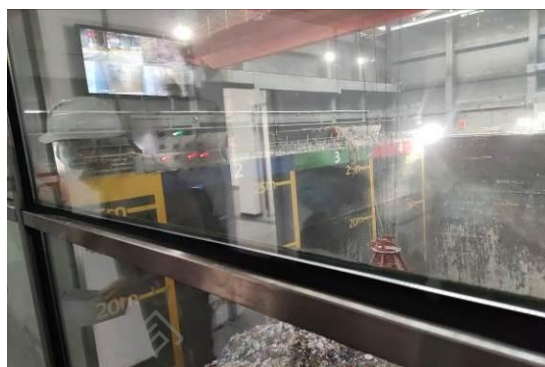
密闭的垃圾贮坑
