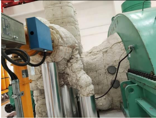
高温管道隔热保护
