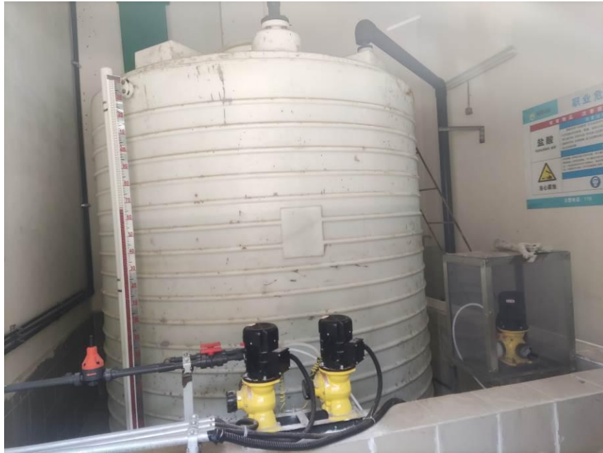
储酸间冲淋洗眼装置现场照片
