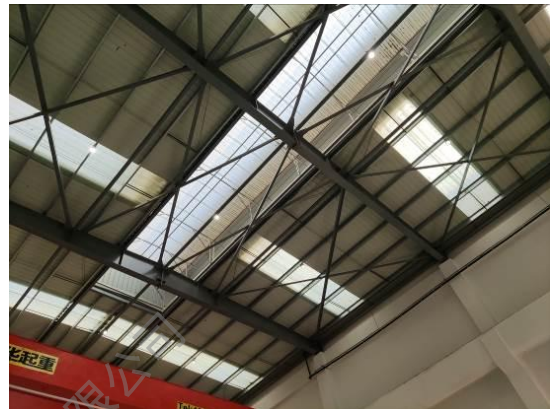
汽轮机间屋顶通风气楼
