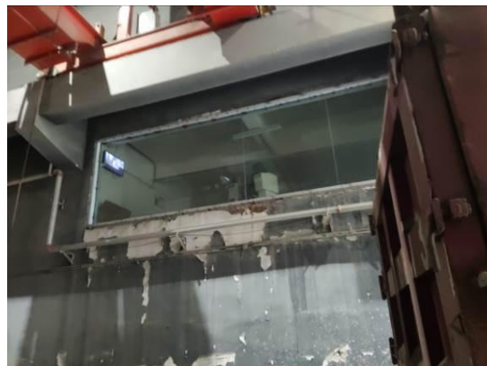
独立、阻尘渣吊控制室
