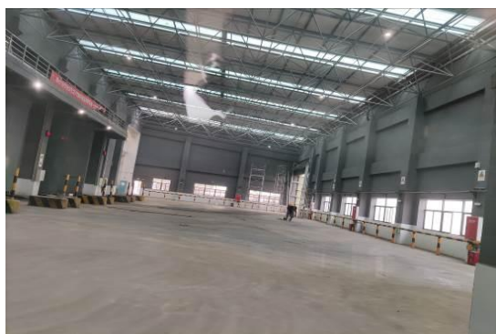
密闭(微负压)的垃圾卸料大厅
