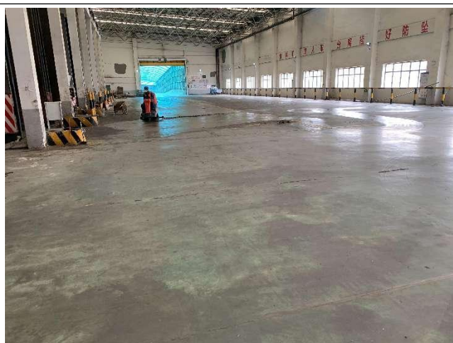
垃圾卸料平台
