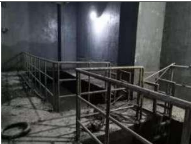
渗滤液收集池
