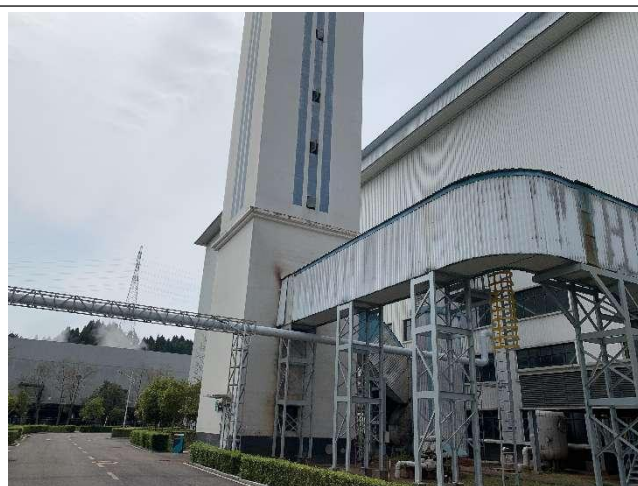
焚烧炉排气筒
