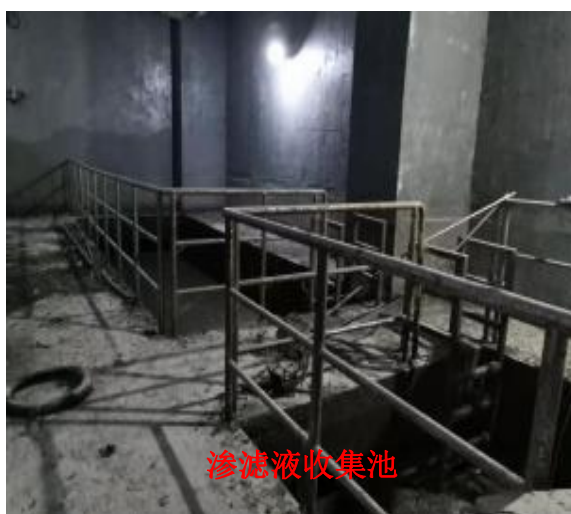
图 4-2 池体现场情况
