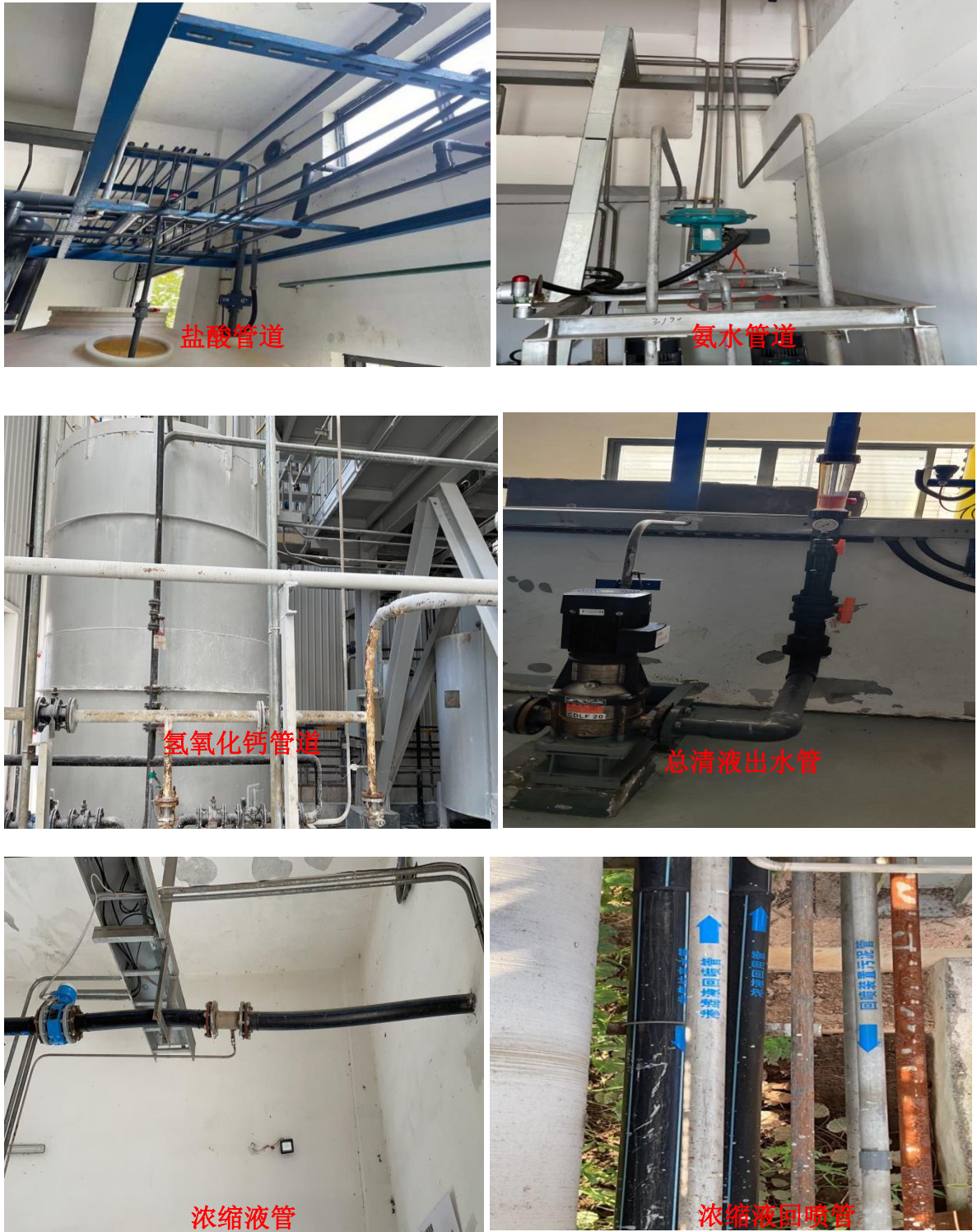
图 4-3 物料输送管道
